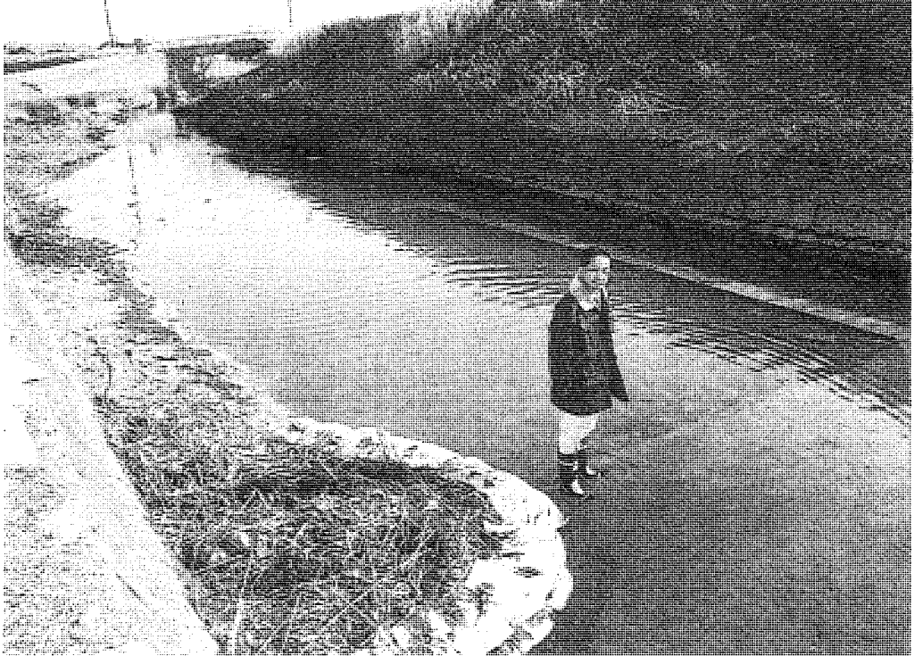
コンクリート底を剥がしてできた淵は12m×7.5m。水深30～40cm。春になって水が温めば、驚くほど多くの小魚が集まってくるはずだ。
