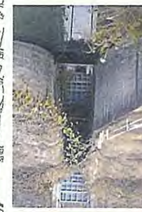
左森悪水樋管
