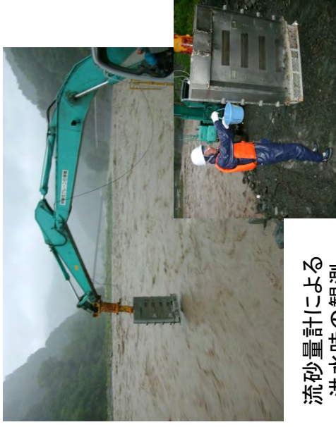
採砂ピットによる 掃流砂の調査観測
