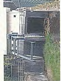
左川田排水樋管背後地
