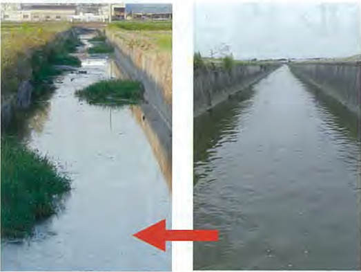
家田病院の近くを南北に流れる中大排水路。幅4mの水路が、左のように変化した。活動後は、毎年、カルガモが子育てをする。
