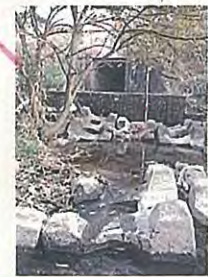
左川田排水樋管
