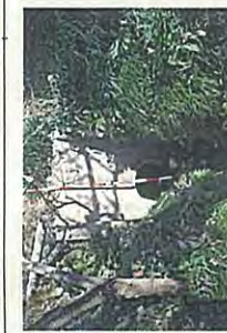
左上和合排水樋管(上流)2
