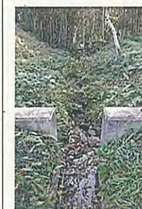
左上和合排水樋管(上流)3
