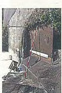
左上和合排水樋管(上流)3
