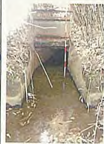
左上和合排水樋管
