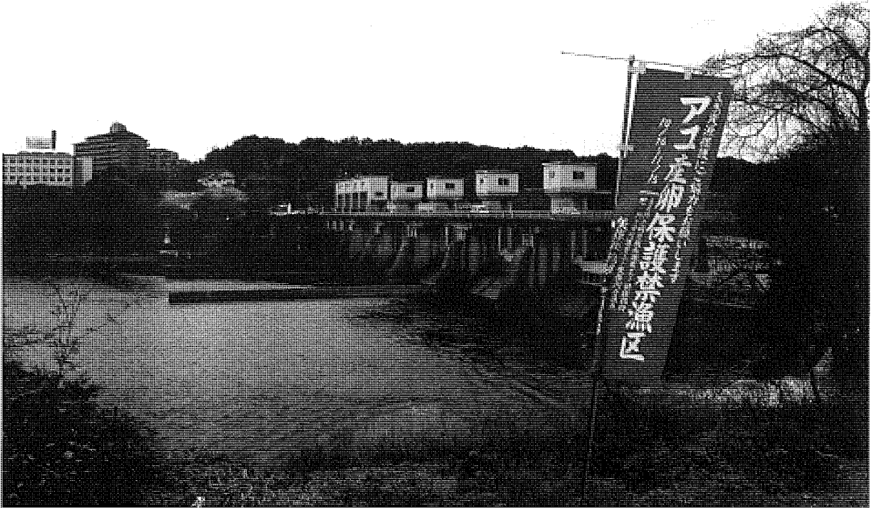
矢作川最下流の農業用水ダム・明治用水頭首工。最近では天然アユの稚魚遡上量観測施設、遡上稚魚の上流へのトラック輸送基地、人工産卵場などの多目的に利用されている。
