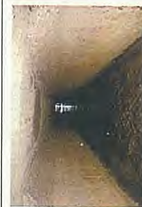
左上和合排水樋管2
