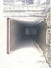
左川田排水樋管2
