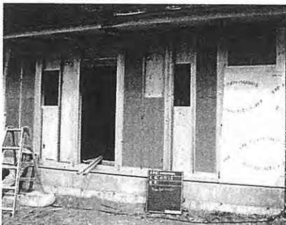
木質断熱材敷込
