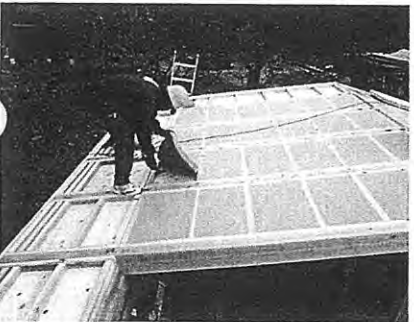
木質断熱材敷込
