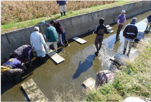
水路作業の様子
