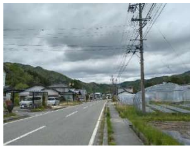
国道418号、平谷郵便局付近の家並み、ビニールやP0フィルムなどで作られた農業・園芸用施設
