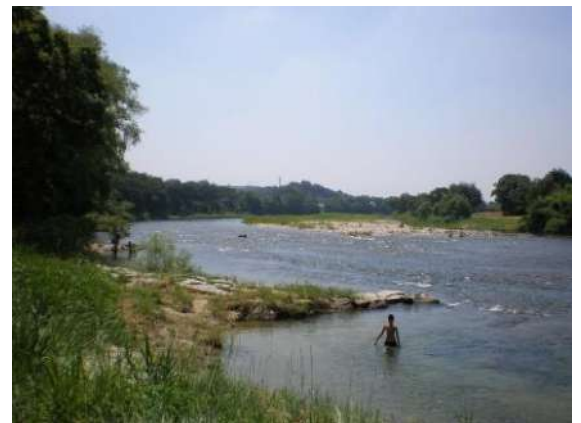
現在の矢作川水制工群 ～古巖から百々貯木場まで延伸される～
