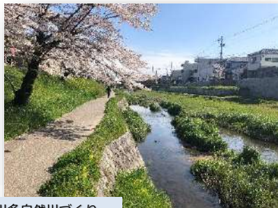
8月末豪雨後の伊賀川多自然川づくり
