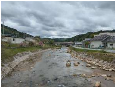
平谷川、やくち橋上流・東方向 恵南豪雨災害復旧個所、右の左 岸は平谷村保育所・平谷小学校
