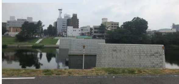
2018. 11月 桜城橋工事
