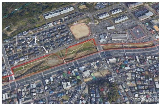
板櫃川の部分拡幅部分
