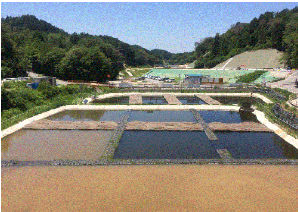
矢作川方式の調整池（豊田テストコース造成工事現場にて撮影：2014年）
