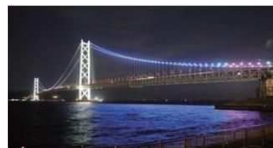
ブルーライトアップ (明石海峡大橋)
