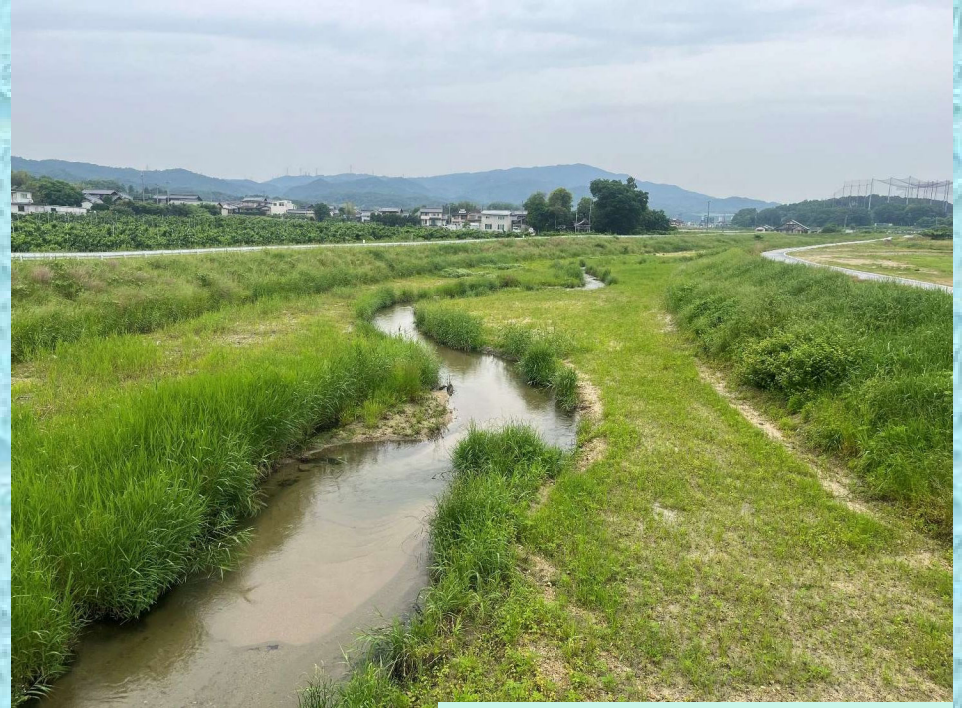
矢作川水系 籠川多自然川づくり
