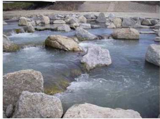
写真-6 越流部とプール部の状況
