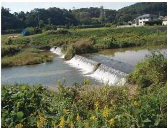
写真-1 代表的な落差工
