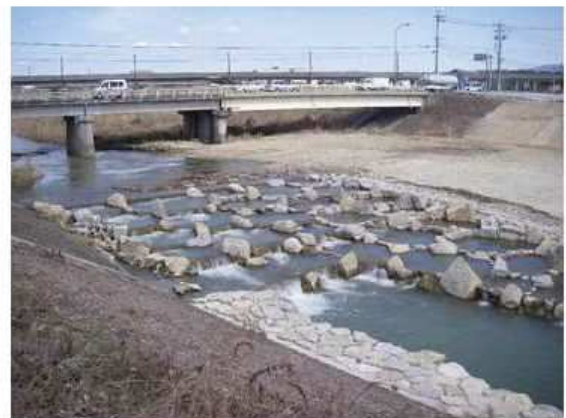
写真-3 新設した魚道全景
