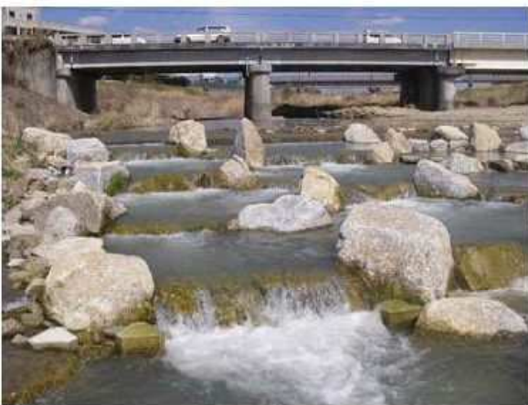
写真-5 魚道施工後の落差
