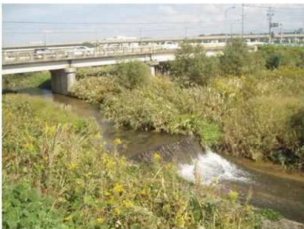
写真-2 魚道設置箇所の落差工
