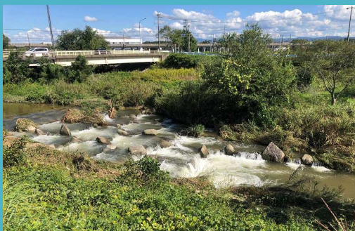
籠川橋下流の多段落差工（半断面）
