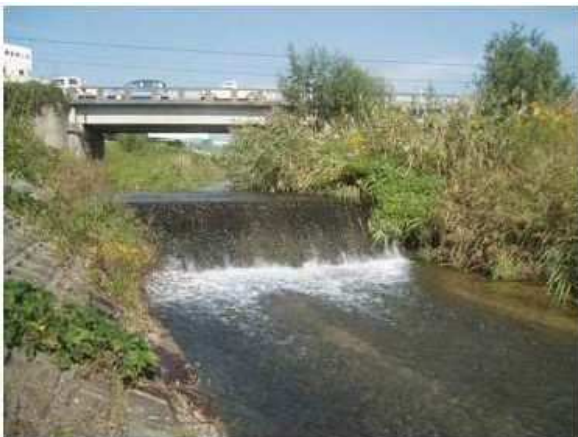
写真-4 魚道施工前の落差
