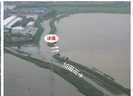
H20洪水/広田川(幸田町)の決壊状況
