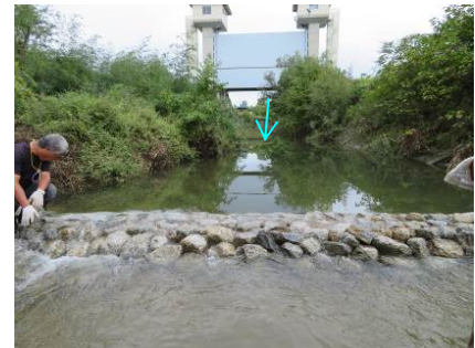
堰上げ式魚道施工状況
