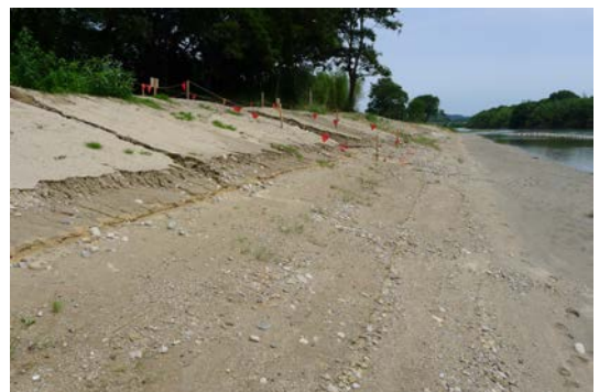
3割勾配の法面の状況
