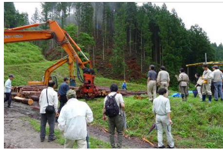
松下薪材間伐作業現場
