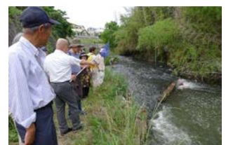
家下川合流点段差改善箇所
