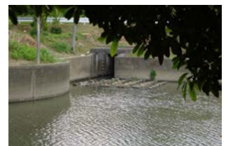
承水溝一矢作川の合流箇所
