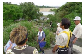
家下川合流点の導流堤
