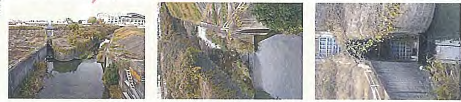
左加茂川水門・森悪水樋管 左加茂川上流 左森悪水樋管
