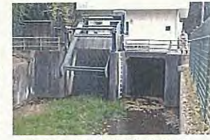
左川田排水樋管背後地
