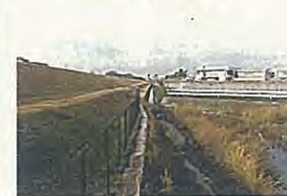
左御立排水樋管背後地3
