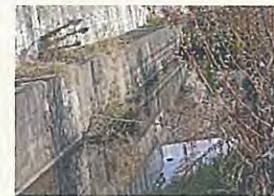
左御立排水樋管背後地4
