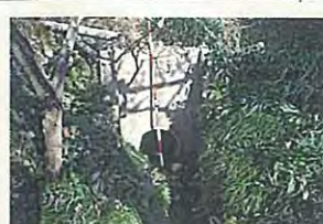
左上和合排水樋管(上流)2
