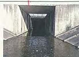
左御立排水樋管
