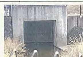
御立排水樋管背後地
