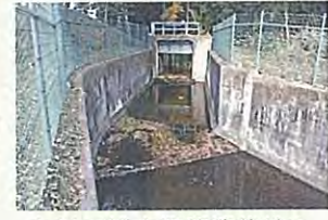
左川田排水樋管背後地2
