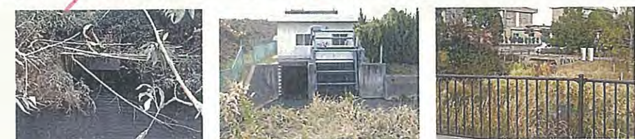
左千石排水機場吐出樋管 左千石排水機場吐出樋管背後地 千石排水機場吐出樋管背後地2
