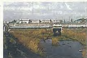
御立排水樋管背後地2
