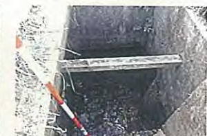
左上和合排水樋管背後地2
