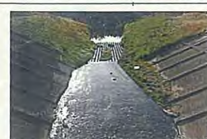
御立排水樋管2
