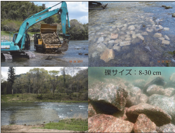
図17 礫置実験区の造成時の様子。
