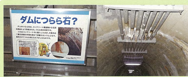
コンクリートから染み出た石灰がたれさがっています。
