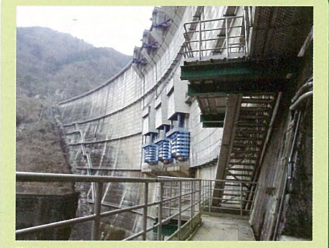
点検のため、ダムの外側を歩く通路で歩廊といいます。
