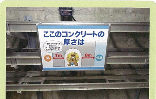
このコンクリートの厚さは 7m 8m ダムの厚さは、一番厚いところでも約20メートル。
