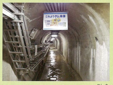
点検のため、ダムの中を歩く通路で監査廊といいます。
