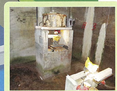
ダムのたわみを計測しています。
