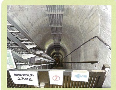
ダムの底に行く階段で、40mの高低差があります。
