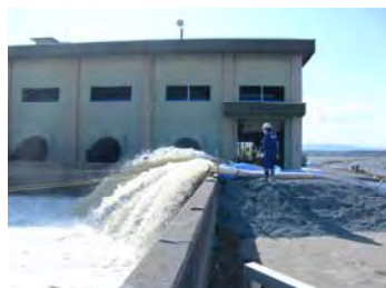
■東日本大震災被災での支援状況 (津波で浸水した地区の排水作業 南相馬市 平成23年4月)
