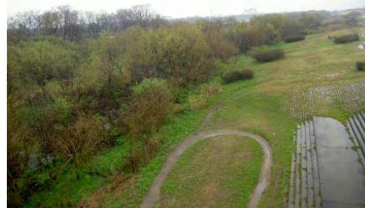
■ 洪水時の流れを阻害する 河道内樹林の繁茂状況
