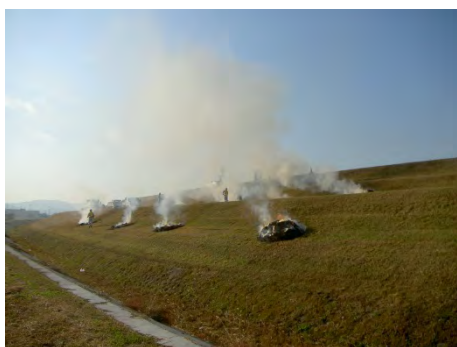
■ 堤防除草作業状況
