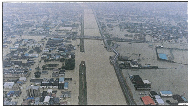
東海豪雨で破壊した新川 2000年9月
