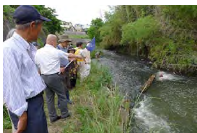
家下川合流点段差改善箇所
