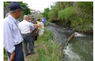
家下川合流点段差改善箇所
