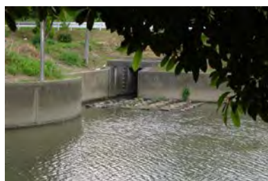
承水溝ー矢作川の合流箇所
