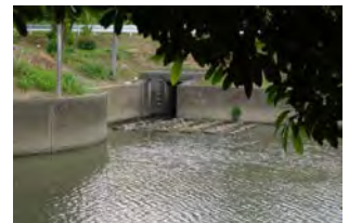
承水溝一矢作川の合流箇所
