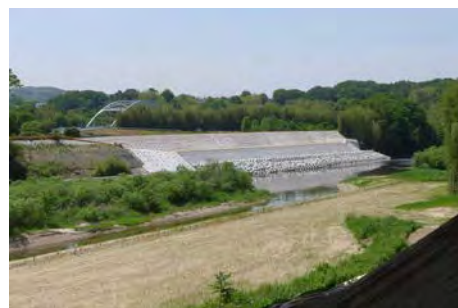
渡合地区の災害復旧の様子
