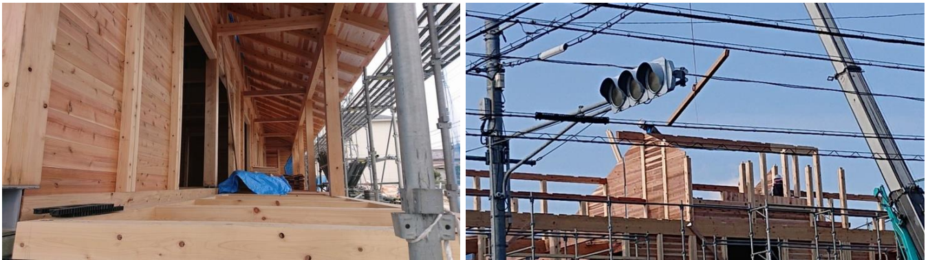
建設中のあおぞら学童のテラス（左）と「秘密の部屋」（右） （あおぞらクラウドファンディング通信HPより）
