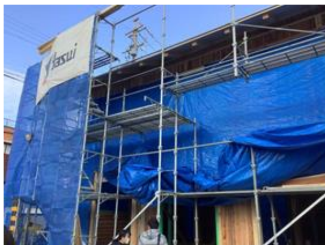
2020年10月 松栄学童上棟式のころの建築現場
