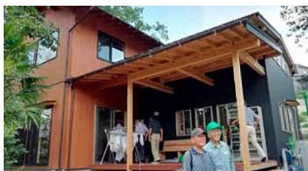
名古屋市昭和区にある「山里学童クラブ」。愛知県の木材を活用して建築された学童保育所第1号（額田木の駅プロジェクトHPより）
