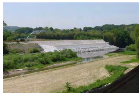
渡合地区の災害復旧の様子
