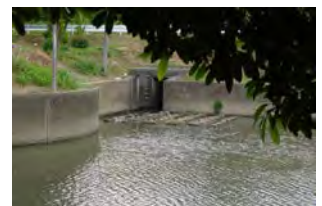
承水溝一矢作川の合流箇所
