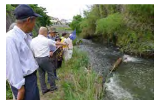
家下川合流点段差改善箇所
