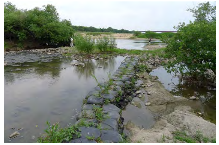
⑤矢作川本川合流部の導流堤設置カ所
