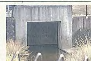
御立排水樋管背後地
