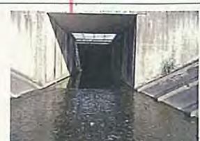
左御立排水樋管
