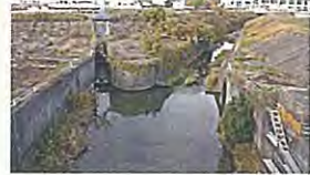
左加茂川水門・森悪水樋管
