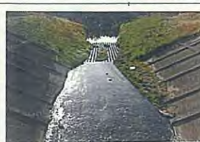
御立排水樋管2
