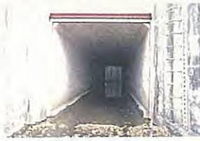
左川田排水樋管2
