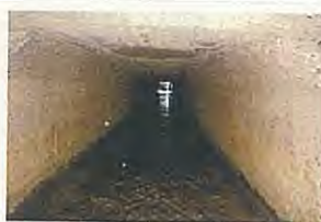
左上和合排水樋管2
