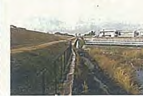
左御立排水樋管背後地3
