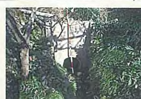
左上和合排水樋管(上流)2
