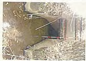
左上和合排水樋管
