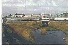
御立排水樋管背後地2
