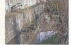
左御立排水樋管背後地4
