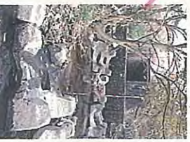
左川田排水樋管
