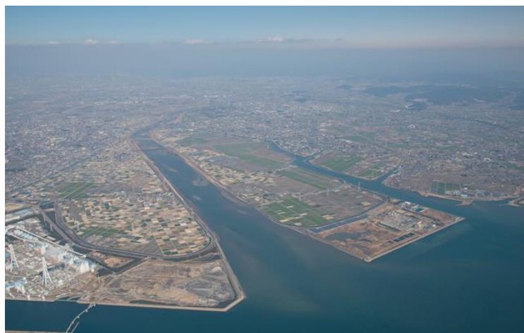
矢作川河口部(豊橋河川事務所HPより)
