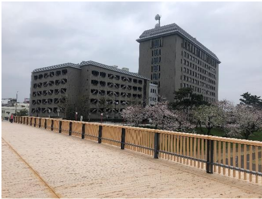
2020年3月完成の乙川「桜城橋」、表面は額田産材で木装化され、その向こうには、愛知県西三河総合庁舎（西三河県民事務所、西三河建設事務所が入居）が見える
