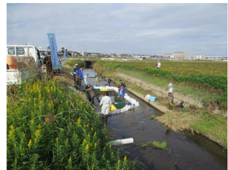
写真4 同上、1号マスの地点 (上流方向。水抜き中。)
