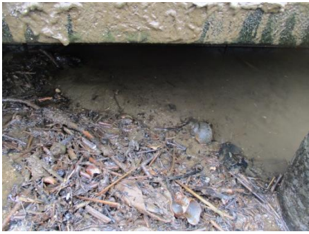
写真9 洞を模して横向きに設置したU字溝、塵芥、スクミリンゴガイ（盤足目リンゴガイ科、外来種） 2)
