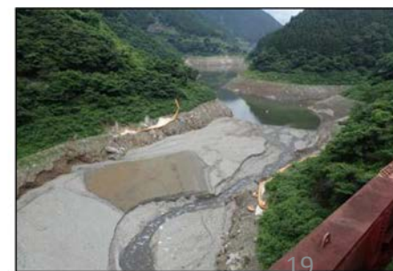
浦山大橋下流 (H29. 7. 28)
