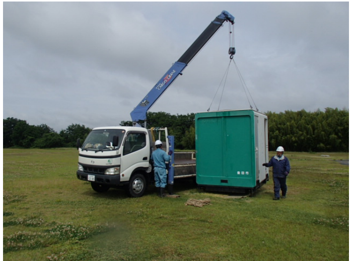
河川内公園の仮設トイレ搬出訓練
