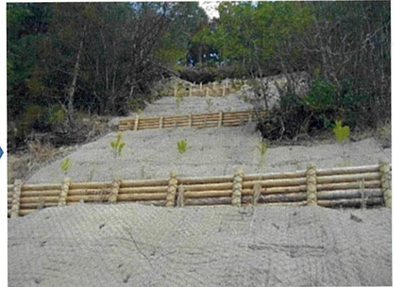
柵工および伏工施工後
