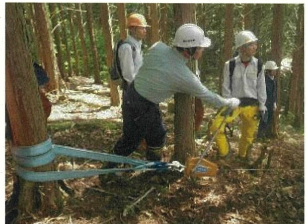
写真：チルホールによるかかり木処理
