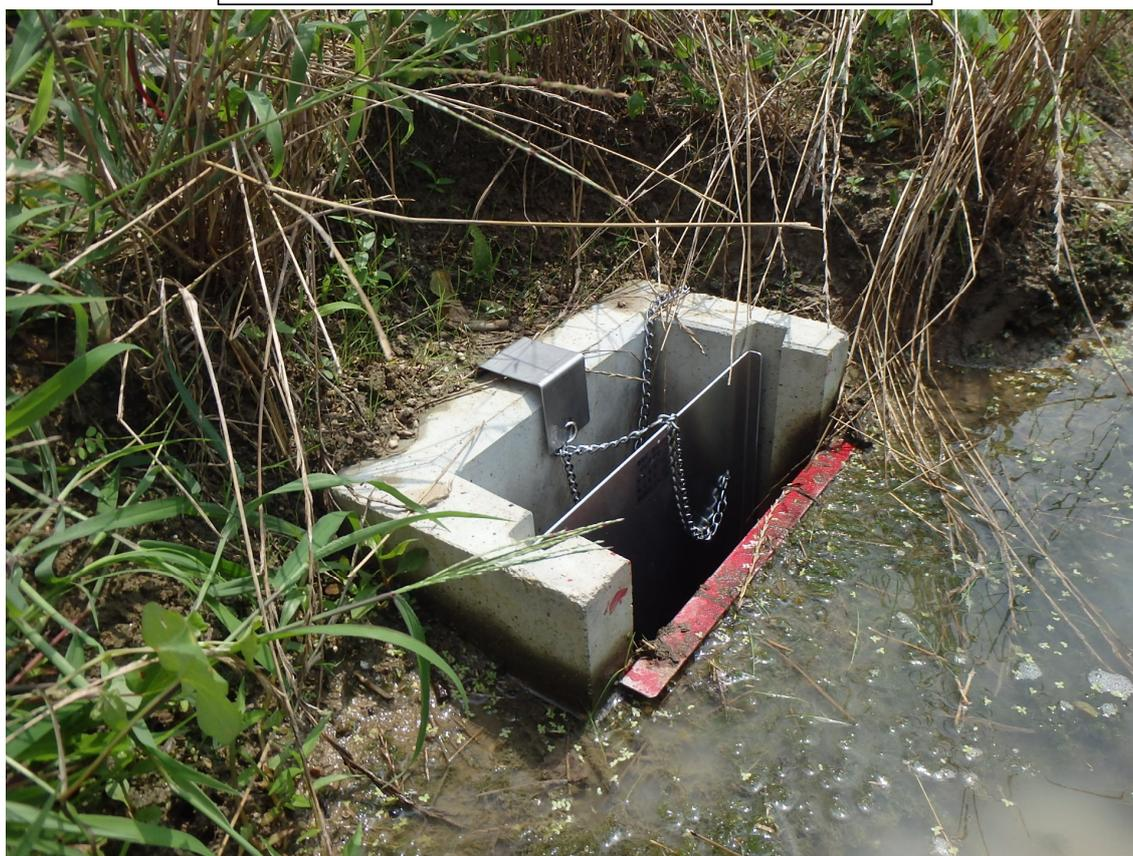
排水マス流量調整方式（貯留時）
