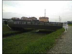
H20施工箇所（屋下北橋）
