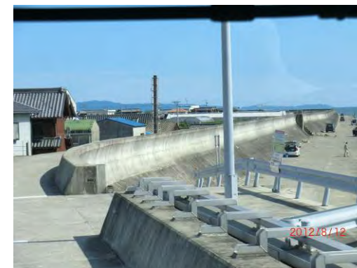
矢作古川護岸進入口
