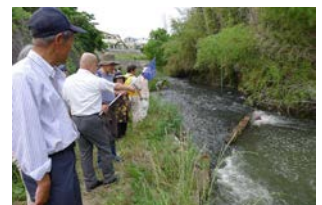
家下川合流点段差改善箇所
