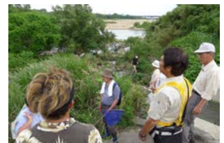
家下川合流点の導流堤
