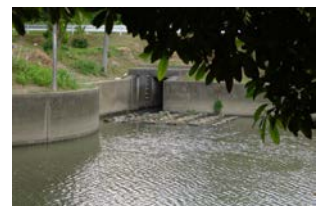
承水溝一矢作川の合流箇所
