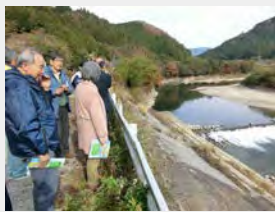
貯砂ダム下流恵那市側の土砂搬出箇所の見学
