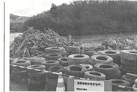
鵜の首の掘削工事では、投棄タイヤ等のゴミも驚くほどたくさん引き上げられた
