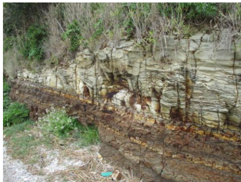
写真 31 海岸小径脇の小崖：師崎層 凝灰質泥岩・シルト岩互層及び砂岩
