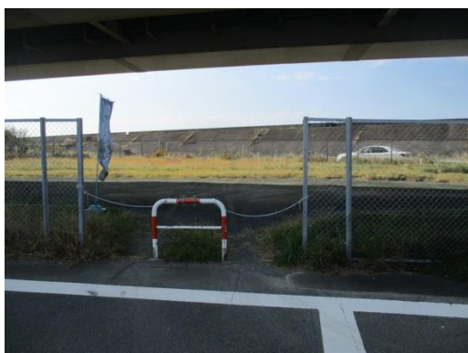
写真1 西浜大橋東側の高架下駐車場（地元管理）
