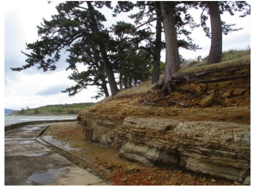
写真 38 道路沿い崖 (風雨侵食で後退)
