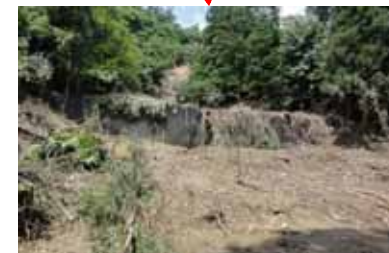
治山ダムで土砂を捕捉
