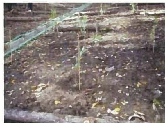
【崩壊地における植栽の実施例】 植栽と併せて、周辺森林で間伐した伐採木を利用した筋工を実施しています(岡谷市小田井沢)
