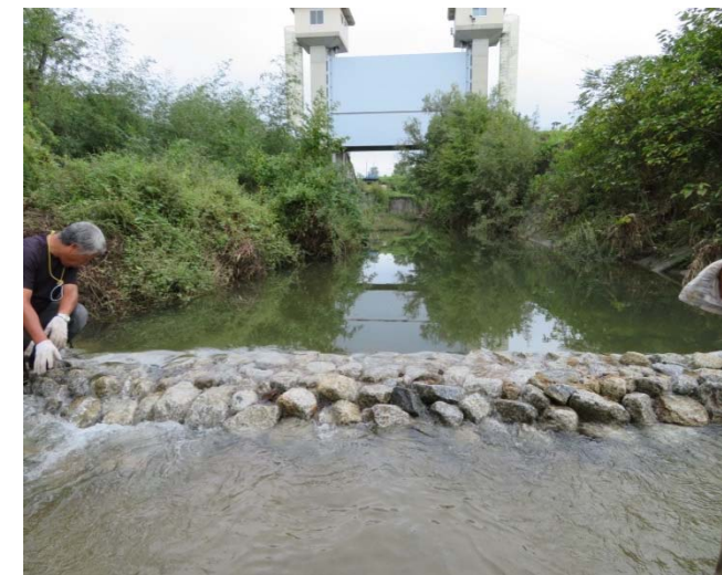
堰上げ式魚道施工状況
