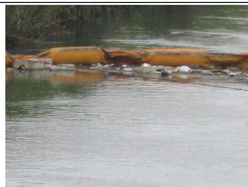
写真 12 同左、シルトフェンスに捕捉された流下ゴミ
