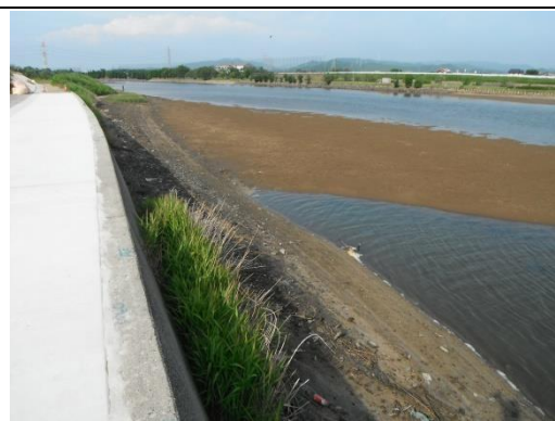
写真 14 矢作古川（松大橋上流・右岸）2015.6.24
