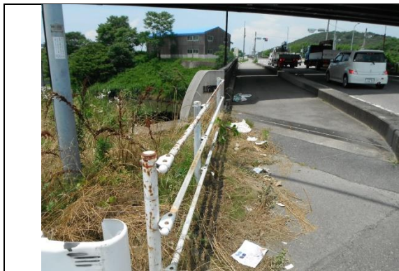
写真 9 矢作古川支川・安藤川（江原小橋）欄干端
