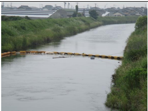
写真 11 北浜川下流（刈宿橋下）2017.6.29
