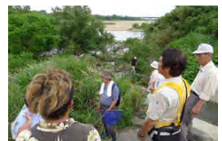
家下川合流点の導流堤
