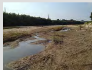
台風18号の出水で埋もれた水路
