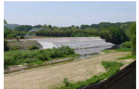
渡合地区の災害復旧の様子
