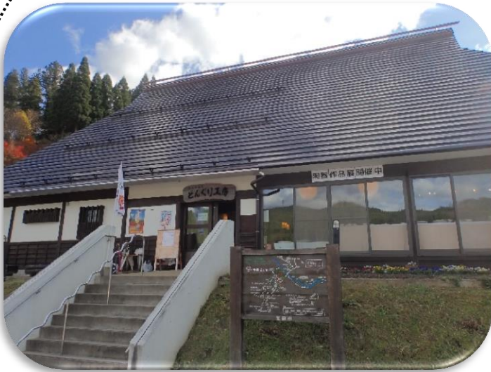
豊田市稲武どんぐり工房 (明治12年の民家を移築)
