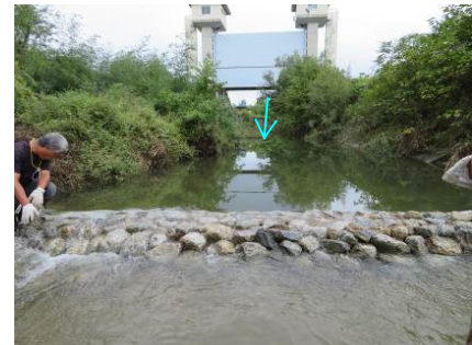
堰上げ式魚道施工状況
