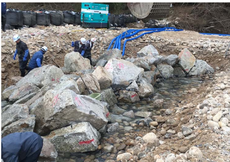
図 5 瀬への石組埋設の試験施工
