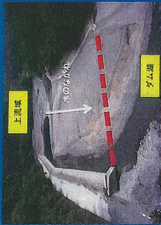
貯砂ダムに土砂が堆積し、堤体を乗り越えてダム湖へ流入
