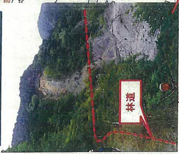
山腹崩壊によって林道が断絶
