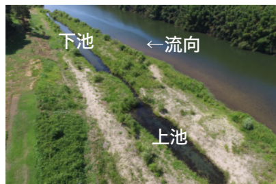
写真-1,2 現地状況
