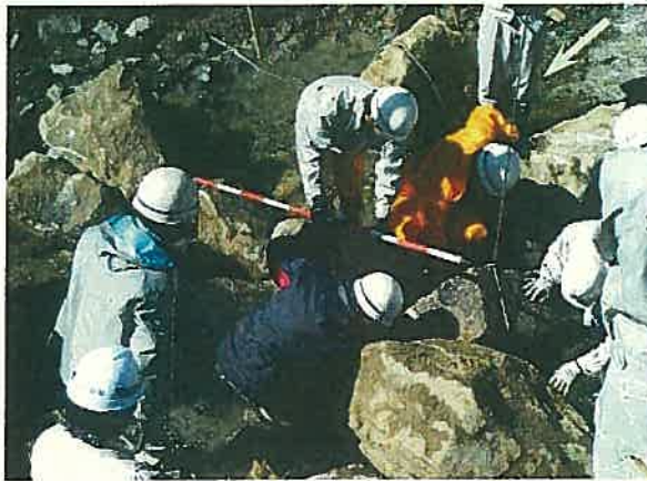
力石設置時と同様に根石により谷形を作る
