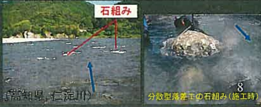
■分散型落差工の事例
